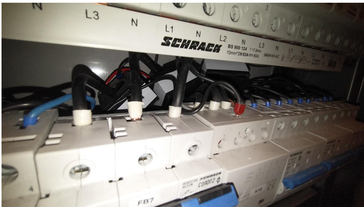
Rysunek 6. Montaż przekładników na obwodzie HVAC
